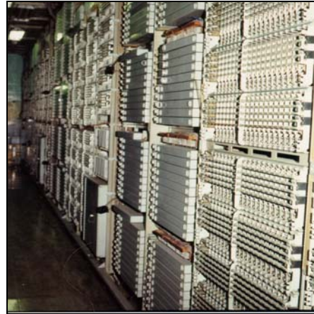
Gambar 10.14. Crossbar switch pada sentral telepon
