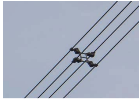
Gambar 4.34 Spacer untuk konduktor berkas 4 kawat (quadruple)
