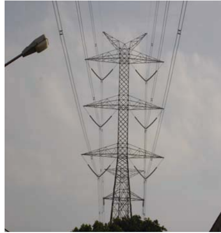
Gambar 4.29 Konfigurasi Isolator tower Suspensi SUTET 500 kV
