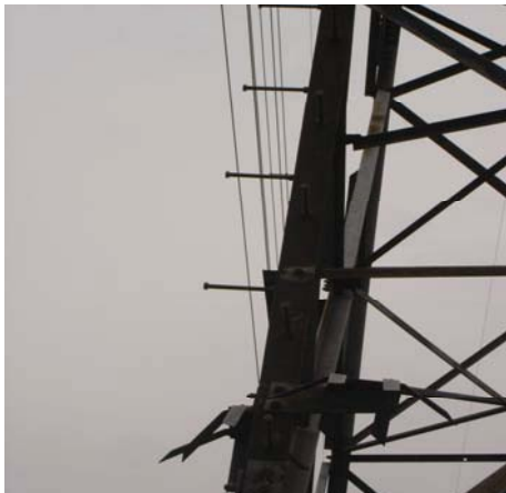
Gambar 4.19 Baut Panjat (step bolt)
