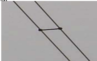
Gambar 4.33 Spacer untuk konduktor berkas 2 kawat (twin conductors)
