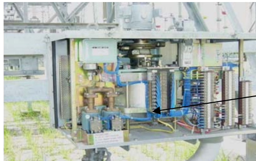
Gambar 5. 13. Mekanik PMS dengan penggerak motor Tenaga penggerak pneumatik (tekanan udara) Tekan udara dapat diperoleh dari kompresor udara sentral yang terpasang dalam rumah kompresor.
