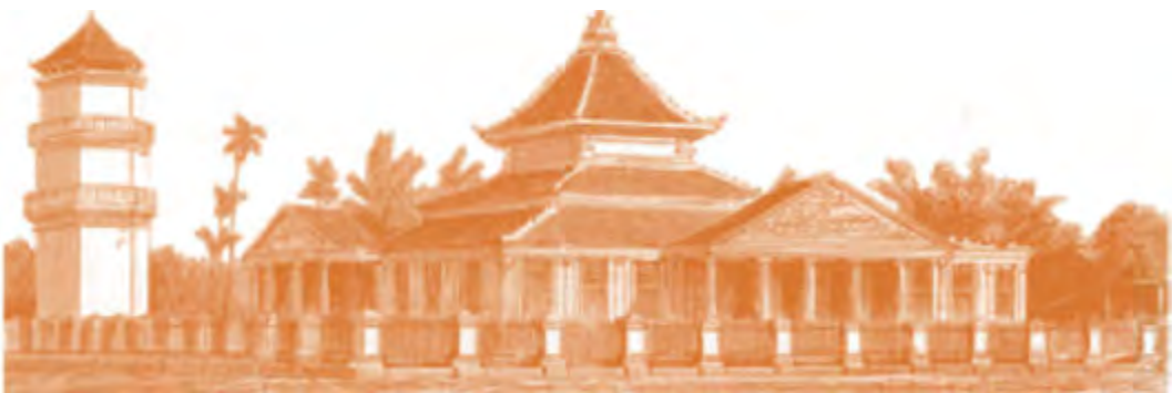
Gambar 3.10 Masjid Agung Palembang yang dibangun pada masa pemerintahan Sultan Mahmud Badaruddin
