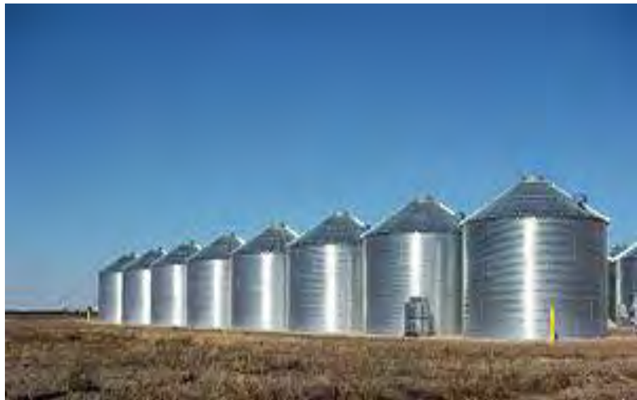
Gambar 95. silo sebagai sarana penyimpanan biji-bijian
