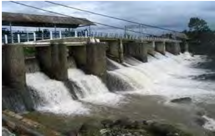
Gambar 16. Air waduk atau bendung
