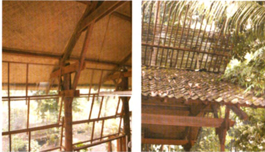
Gambar : Konstruksi atap (kiri) dan konstruksi dari bambu untuk melindungi atap genteng dari kerusakan terkena buah jatuh (kanan) Sumber : Rumah Ide (2007:60)
