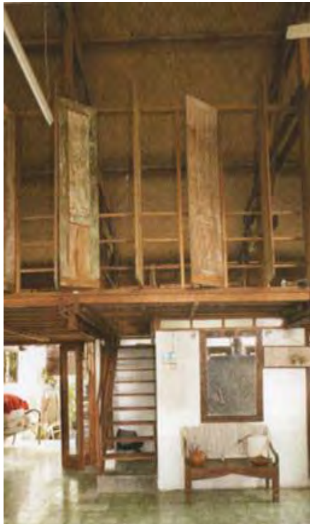
Gambar : Emen pintu lama sebagai pembatas ruang tidur yang bisa dibuka tutup Sumber : Rumah Ide (2007:59)
