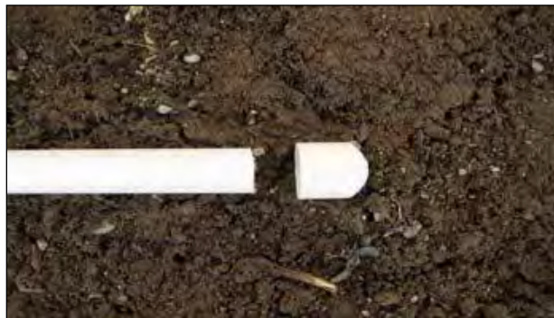
Gambar 98. Penggunaan Penutup pada Ujung Pipa PVC
