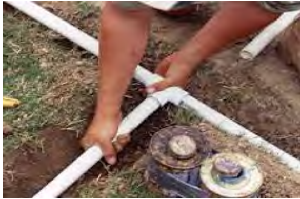
Gambar 96. Penyambungan Pipa PVC dengan lem pipa
