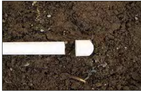
Gambar 114. Penggunaan penutup pada ujung pipa PVC
