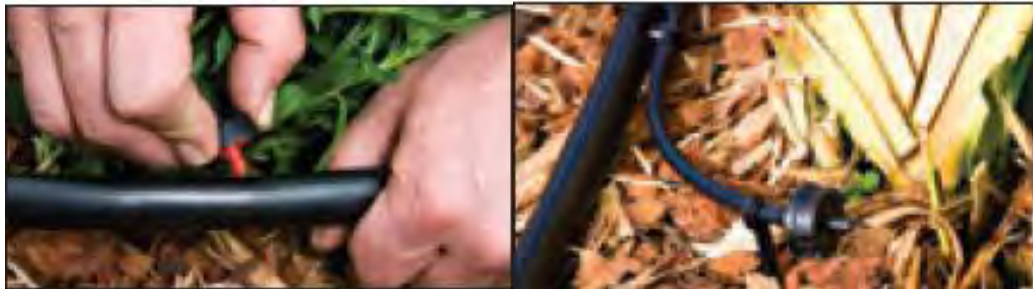
Gambar 119. Pemasangan alat aplikasi penetes pada pipa PE
