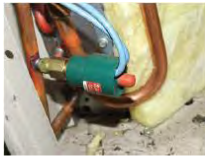
Gambar 5.15 High-pressure Switch pada Unit Tata Udara Domestik
