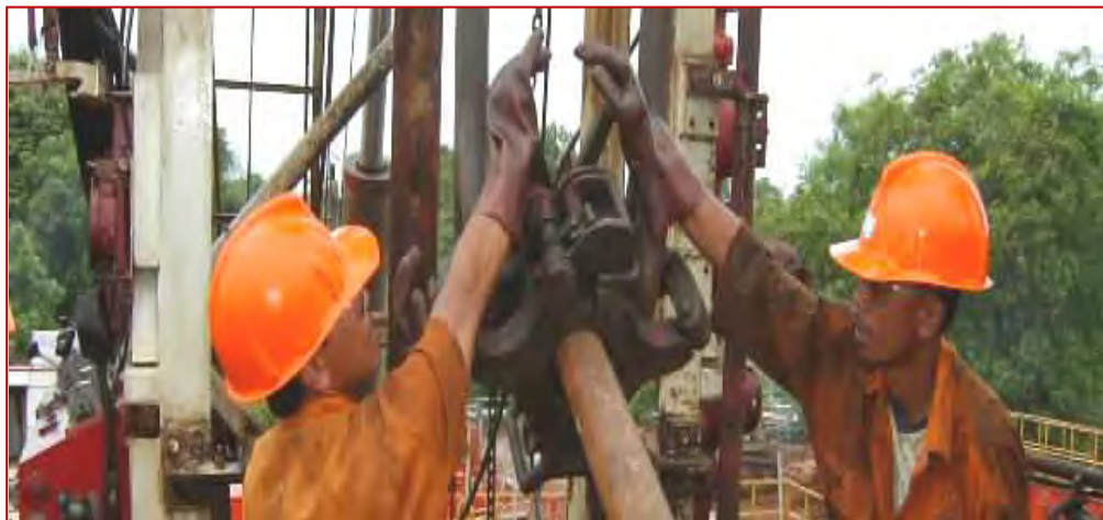
Gambar 5.3 Mengangkat Pipa dari Pipe Rack
