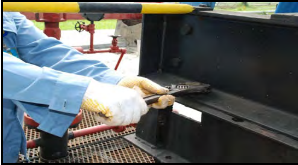
Gambar : 7.6 Memeriksa mur dan baut pondasi
