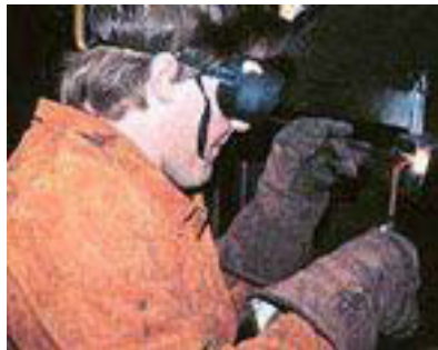
Gambar pekerjaan mengelas dengan oxy-acetylene
