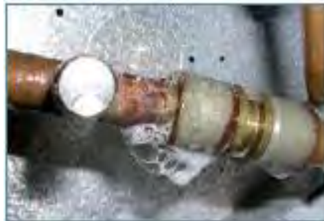
Gambar 2.1 Pemeriksaan Kebocoran dengan Busa Sabun dan Leak Detector
