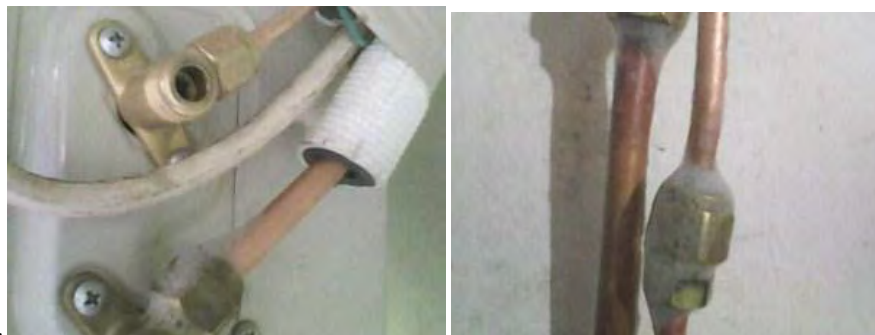
Gambar 6.10_Pemeriksaan Kebocoran Pada Sambungan Pipa AC Split
