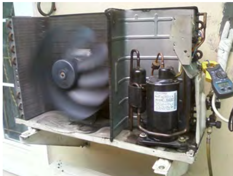
Gambar 2.6Konfigurasi Komponen Unit Out Door AC Split
