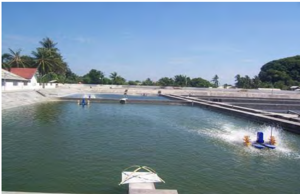
Gambar 21. Tambak intensif konstruksi beton
