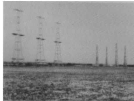
Instalasi radar Chain Home, tiga tower besi sebelah kiri antena pemancar dan empat buah tower kayu sebelah kanan antena penerima
